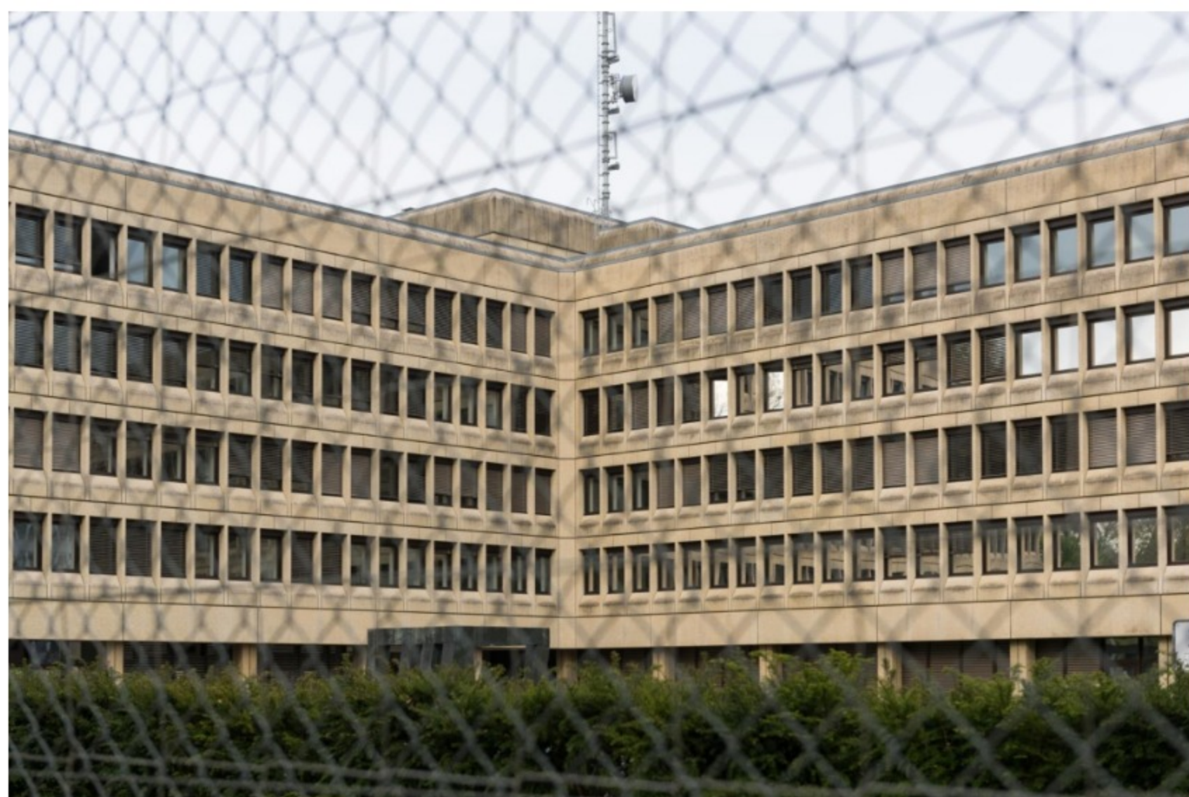
Das NDB-Gebäude an der Berner Papiermühlestrasse. (Bild: Samuel Schalch (Archiv))
